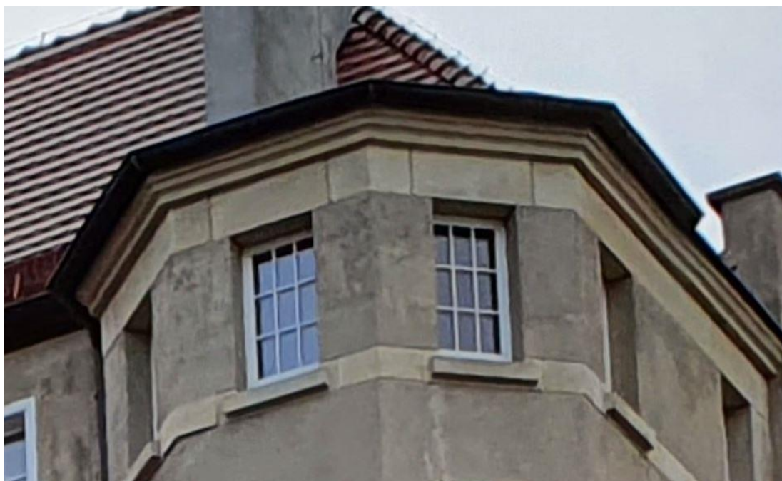
Zdjęcie 35 : Okna 02D, przeznaczone do wymiany na nowe, jako kopię istn, rozrysowane w detalu Źródło: archiwum prywatne autora.
