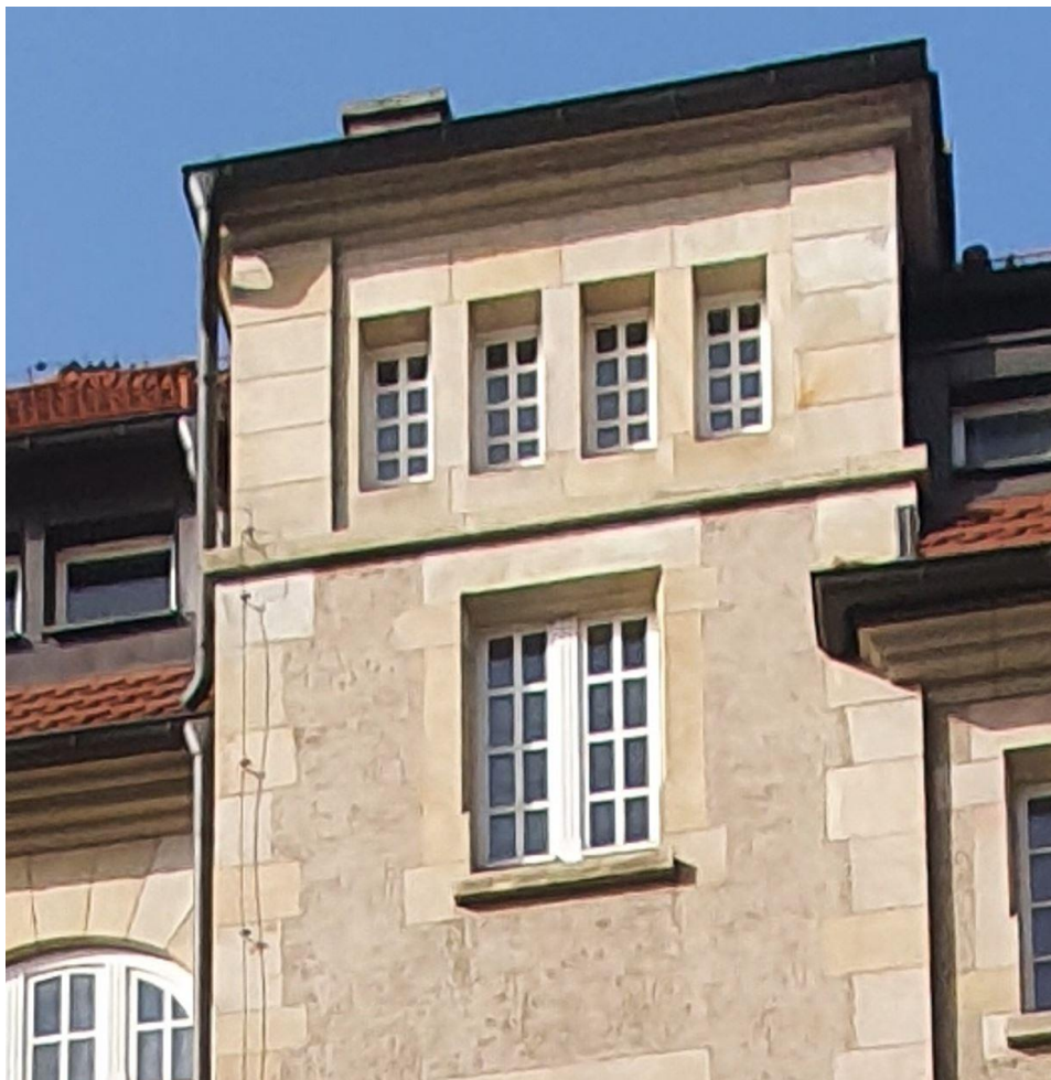
Zdjęcie 35 : Okna 03D, 04D, przeznaczone do wymiany na nowe, jako kopię istn, rozrysowane w detalu Źródło: archiwum prywatne autora.
