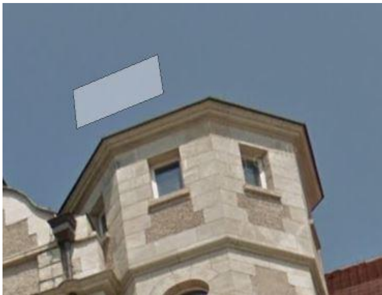
Zdjęcie 37 : Okna 05D, przeznaczone do wymiany na nowe, wykonane jako kopia istn. Źródło: archiwum prywatne autora.
